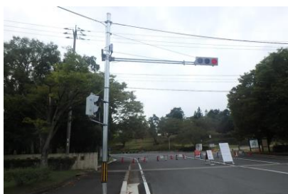
交通安全施設 信号機設置工事
