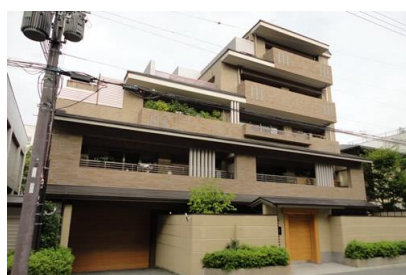
（株）大林組 グランエスバス御所東新築電気設備工事 平成19年8月竣工 請負額/26,000千円
