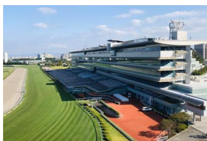
(株) きんてん 阪神競馬場場内改修工事 平成18年11月竣工 請負額/76,000 千円
