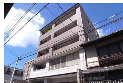
（株）大林組 グランエスバス御所南新築電気設備工事 平成19年8月竣工 請負額/26,000千円
