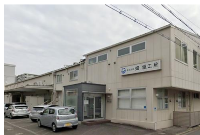
要建設(株) 燐鐵工所改修工事 平成 22 年 9 月竣工 請負額/13,200 千円
