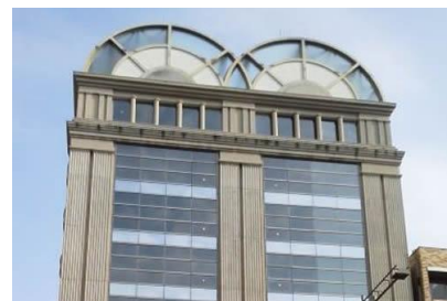
宝建設（株） イタリヤード本社社屋新築電気設備工事 平成 2 年 7 月竣工 請負額/72,900 千円
