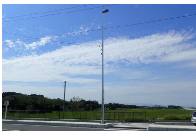
交通安全施設 照明灯設置工事
