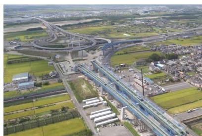
(株) 正興電機製作所 城陽 IC～八幡 IC 受配電自家発電設備工事 平成29年6月竣工 請負額/55,080 千円
