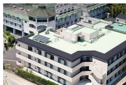
（株）ツバサエ務店 旭ヶ丘老人ホーム増設電気設備工事 平成4年2月竣工 請負額/42,230千円
